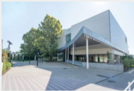
都立多摩図書館外観
