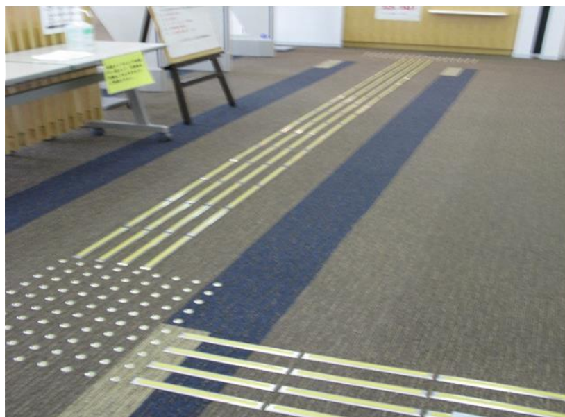
点字ブロックの設置
